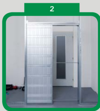
2 Usazení pouzdra do spodního profilu SDK
