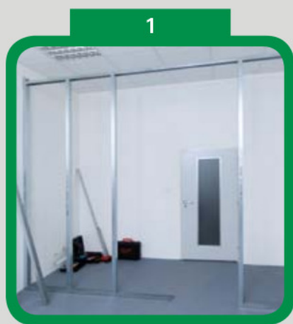
1 Příprava profilů SDK pro usazení pouzdra
