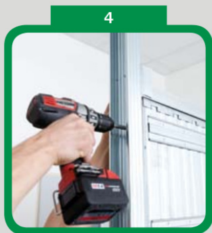
4 Přípevnění pouzdra ke konstrukci SDK
