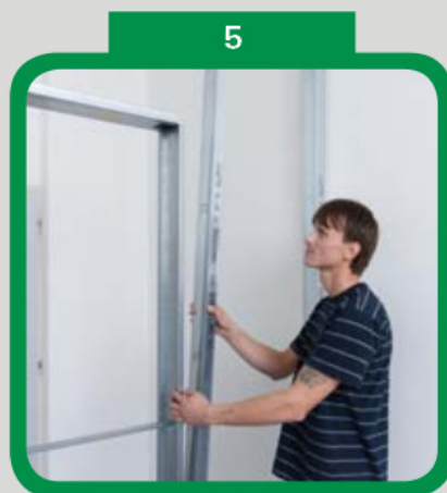
5 Montáž protilehlé strany SDK konstrukce
