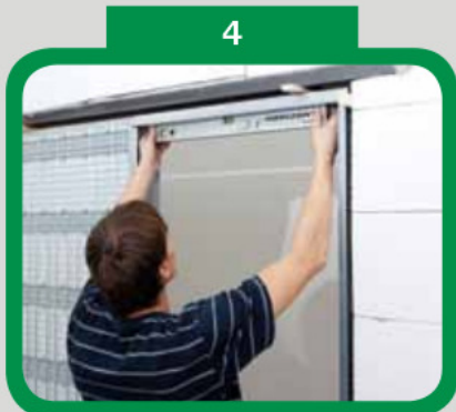
Vyvažte stavební pouzdro horizontálně a vertikálně
