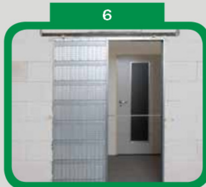
Zapěněné pouzdro ve stavebním otvoru
