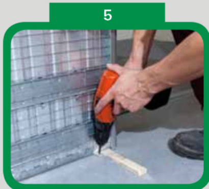
Ukotvíte stavební pouzdro do podlahy
