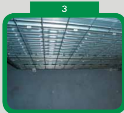
Ukotvíte stavební pouzdro do podlahy
