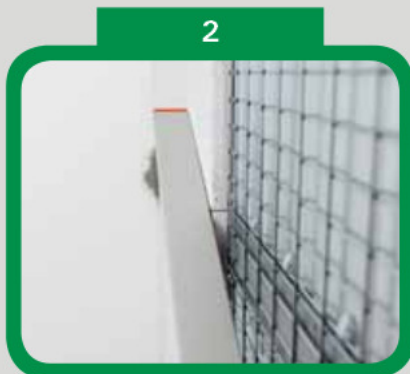
Vložte stavební pouzdro do stavebního otvoru
