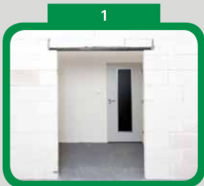
Připravený stavební otvor
